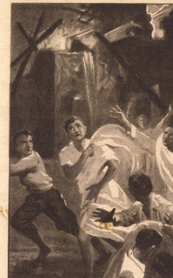
65) Crollo della casa in costruzione.
