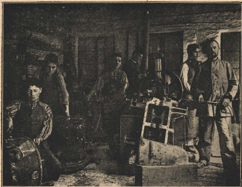
Viedma - Collegio S. Francesco di Sales - Laboratorio meccanico, saldatura autogena.
