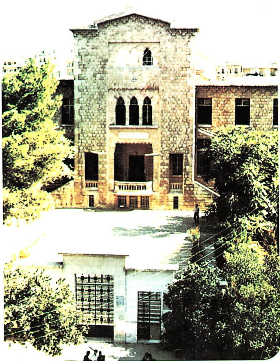
Façade actuelle de la Fondation Georges et Mathilde SALEM, Avenue du Roi Fayçal.
