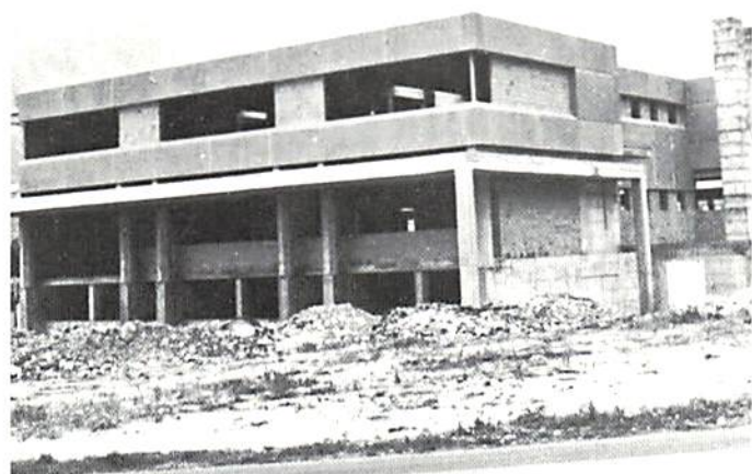
Mosson - Nuove Scuole Medie in costruzione alla «Colombara» vicino alla «fontanella».
