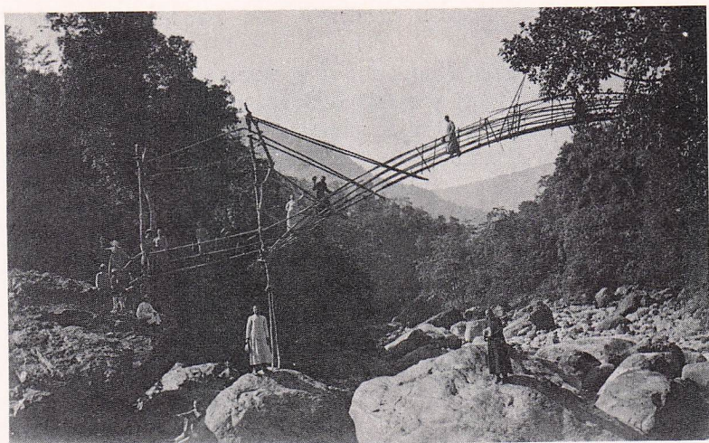
Ponte di canne di bambù, realizzato con grande abilità dagli indigeni, gettato tra le sponde di un torrente.
