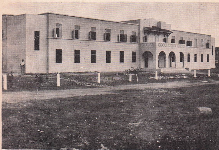
Dos vistas del inicio del Colegio Don Bosco: año 1934, en la parte alta de la ciudad, cerca del acueducto que se ve a la izquierda.
