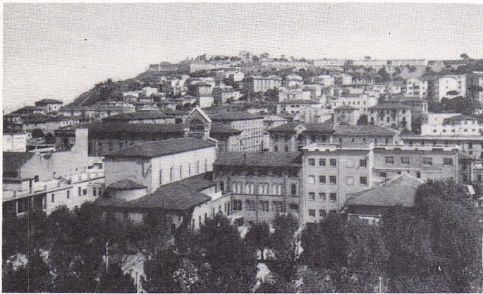
Vista panoramica dell'Opera, e quartiere prossimo alla stazione.
